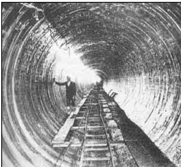
1939 - Construcción del sifón de la Tercera Cloaca Máxima. Fuente: "El saneamiento en el área metropolitana, desde el Virreinato a 1993"...
