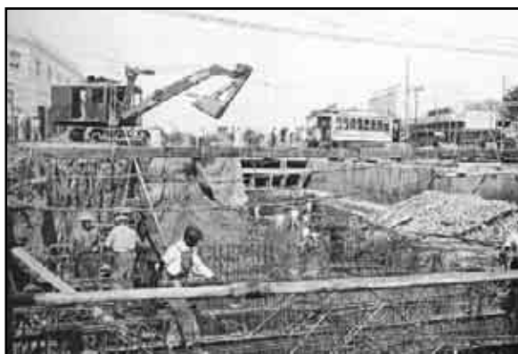
1937 - Tendido de desagües pluviales contemplados en el proyecto Radio Nuevo. 1993"...
